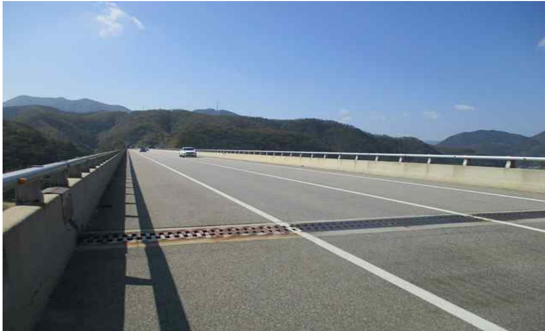
발산1교(양양) 상부 전경
