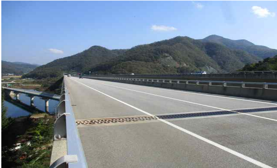
발산1교(서울) 상부 전경
