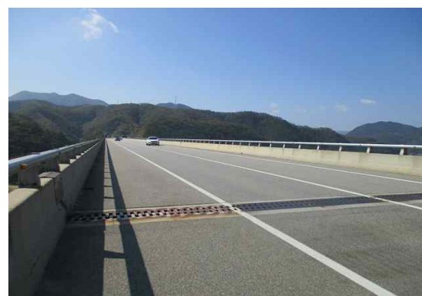
발산1교(양양) 상부 전경
