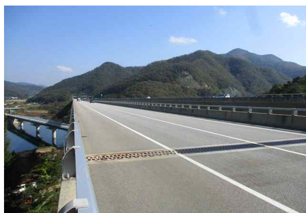
발산1교(서울) 상부 전경
